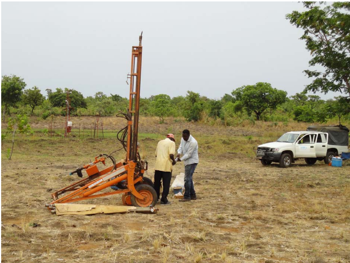
Forage d'un piézomètre à proximité de la station de flux dans un bas-fond sur le site AMMA-Catch Bénin. (Photo prise par M. Boucher en 2013 crédit IRD)
